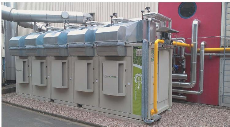
**Figura 4.4** – Microturbina a gás implementada em módulos e em local aberto.
