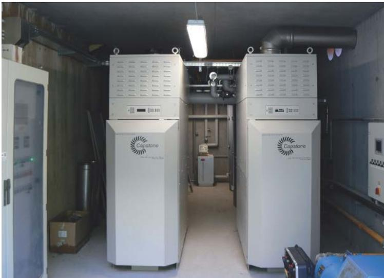
**Figura 4.3** – Microturbina a gás.
