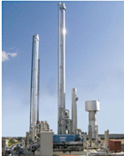
**Figura 10.10** – Unidade de *upgrading* de biogás por lavagem com água.
