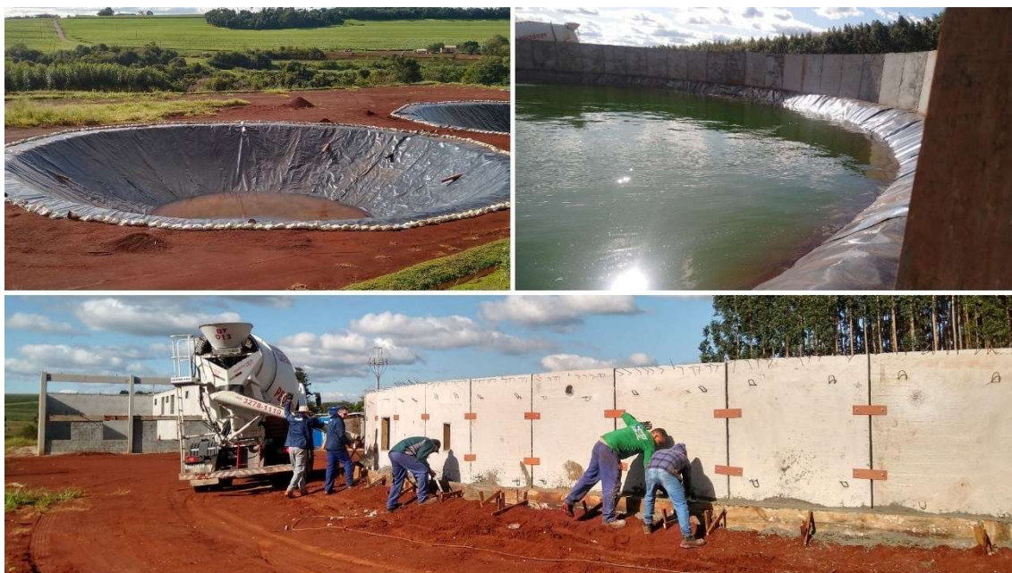
Figura 10 – Execução das obras da Central de Bioenergia a Biogás de Toledo
